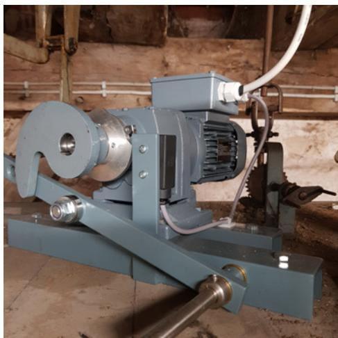
**Einer der neuen Glockenschlagantriebsmotoren**
